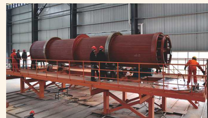
▲ 冷渣机组装中
